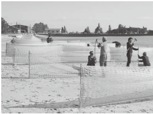
橋杭海水浴場の砂浜に金属性の杭を打ち、ネットを張って固定していく会員等の様子
