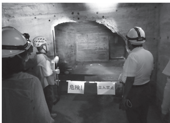
海軍地下送信所内部
