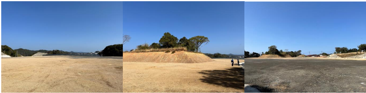
①全景（北東方向）
