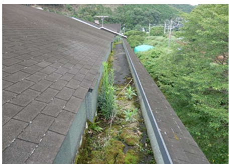
屋根・屋上：排水不良、土砂堆積 (串本西小学校・校舎)
