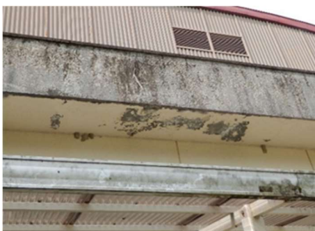
外壁：剥がれ、ひび割れ (串本西小学校・体育館)
