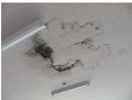
内部仕上：漏水、破損 (西向中学校・校舎)
