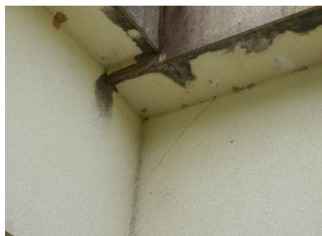
外壁：剥がれ、ひび割れ (串本西小学校・体育館)
