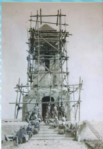
建設中の慰霊碑
