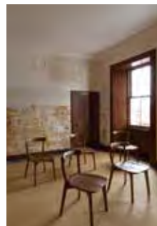
檜野崎灯台旧官舎内部
