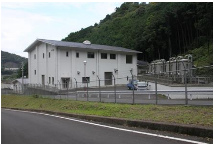
新古田浄水場
