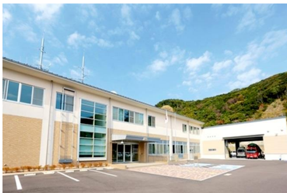
防災センター
