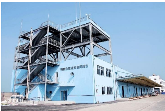
串本地区農林水産物集出荷貯蔵施設
