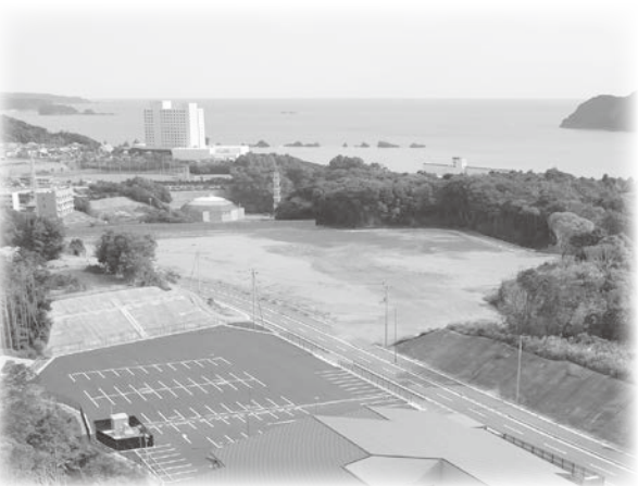
高台の統合小学校建設予定地
