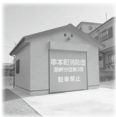
新設された潮岬第3部器具置場
