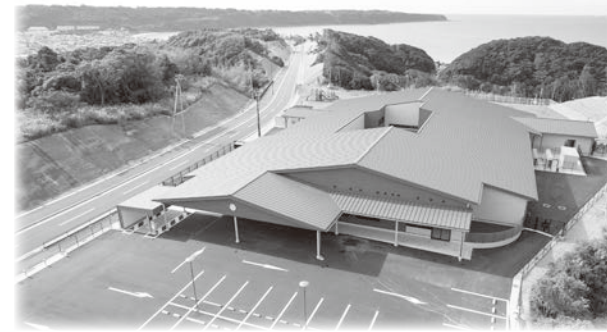
高台に移転したくしもとこども園新園舎
