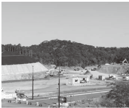
建設が進むすさみ串本道路の串本IC（仮称）付近（サンゴ台）
