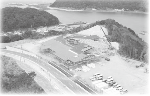
建設中のくしもとこども園新園舎
