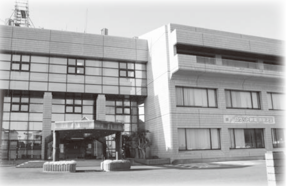
リノベーション実施中の旧古座分庁舎
