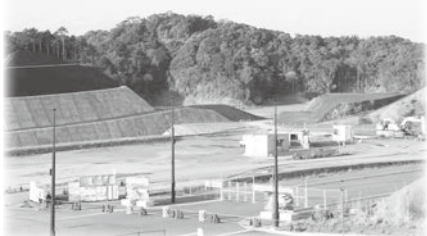
建設途中の「串本 IC（仮称）」周辺
