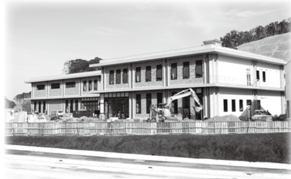
建設中の新庁舎
