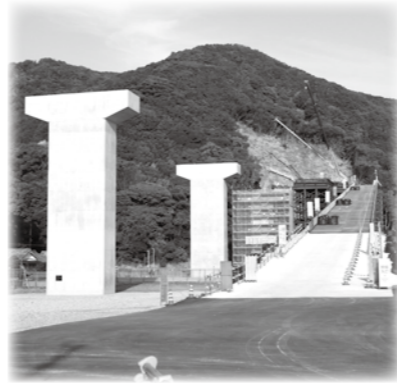
工事が進む「すさみ申本道路」
