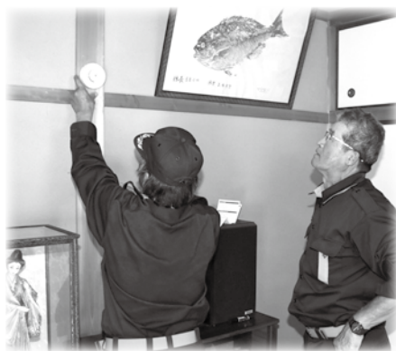
大島3地区での住宅火災警報器設置の様子
