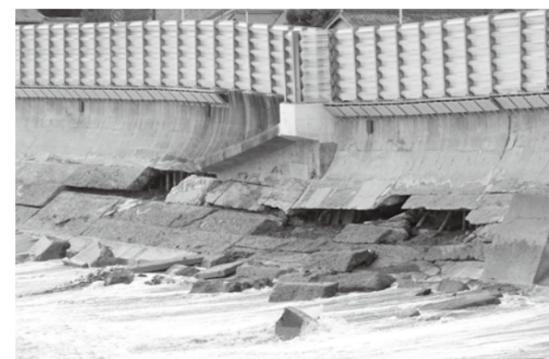
破壊された姫地区海岸沿いのコンクリート擁壁
