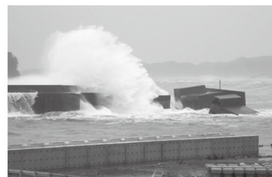
高波で損壊した動鳴気漁港の防波堤
