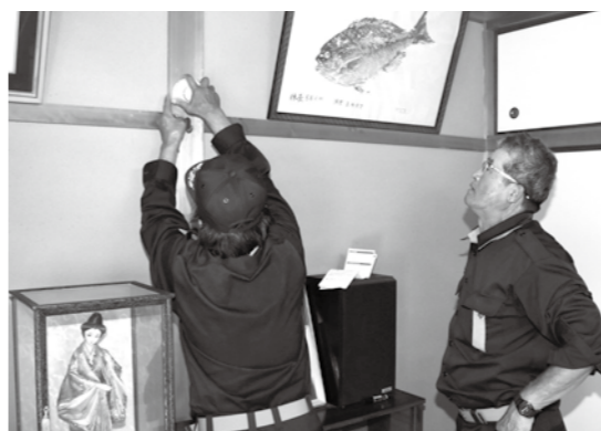
住宅用火災警報器を取り付ける様子
