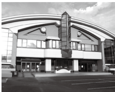
内装工事が完了した串本町文化センター
