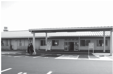
サンゴ台に建設された串本町福祉総合センター
