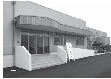
1月8日に竣工式が行われた学校給食センター
