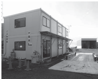
田並ごみ処理場の仮設中間処理施設
