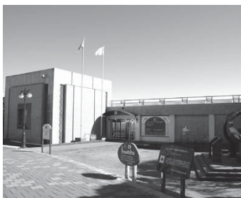
改修を行うトルコ記念館
