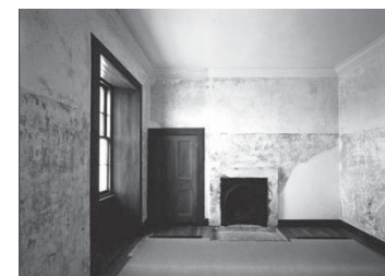
改修された旧官舎内部
