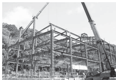
建設中の汚泥再生処理センター
