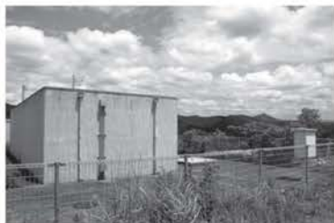
移設する高区配水池
