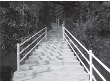
整備された田嶋地区の避難路。24年度避難路整備事業は前年度の予算より約260%増の2,643万2千円とし、危険度の高い箇所を優先的に整備していきます。
