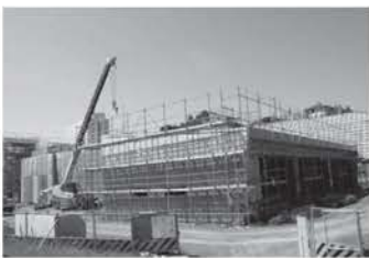
建設中の防災センター
