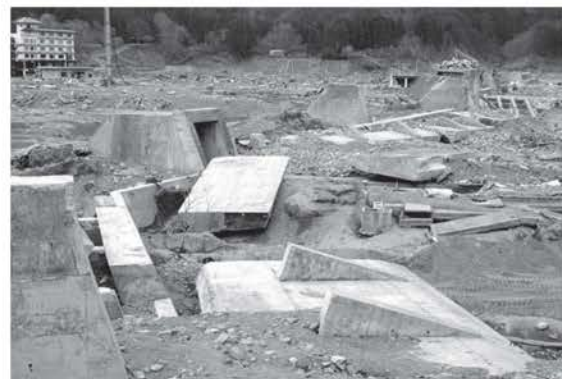
写真① 岩手県宮古市田老地区の10mの防潮堤の倒壊の様子
