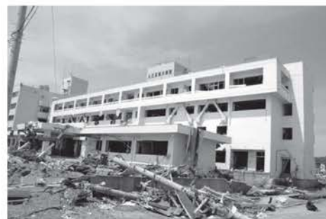
写真② 宮城県南三陸町の4階建ての鉄筋コンクリートビルの被災状況
