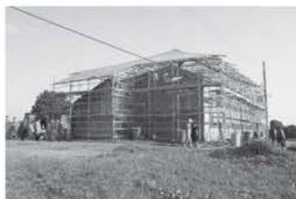
改修中の旧官舎
