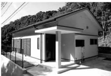
財団法人自治総合センターの助成を受け、このほど古座ヴィラ地区に完成した集会所
