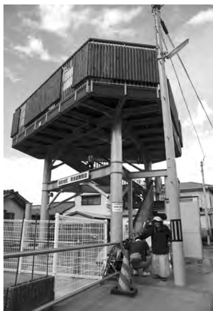
田並地区の津波避難タワー
