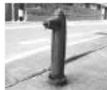
地上式消火栓
