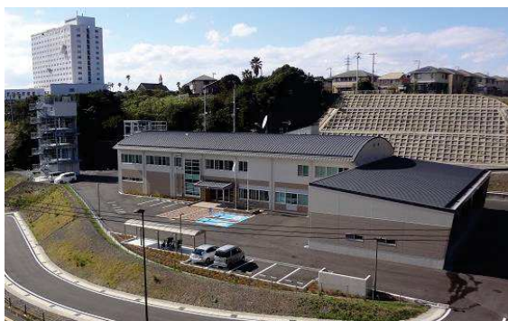
防災センター
