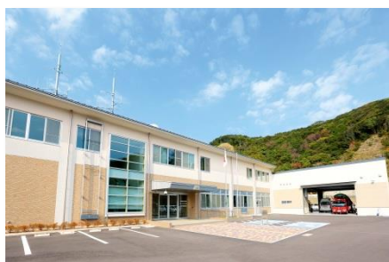
消防防災センター
