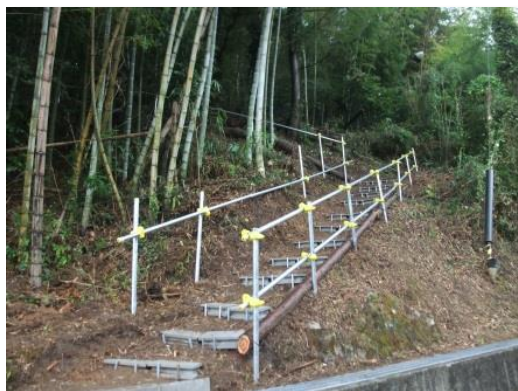
避難路(姫区自主防災会による施工)
