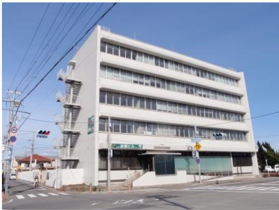
津波避難ビル(NTTビル)
