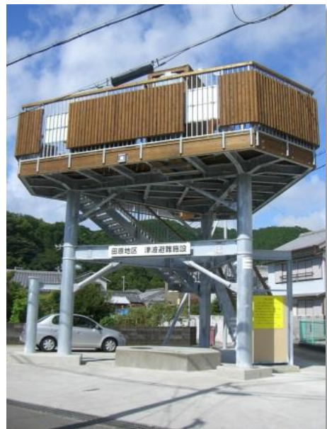
津波避難タワー(田原地区)
