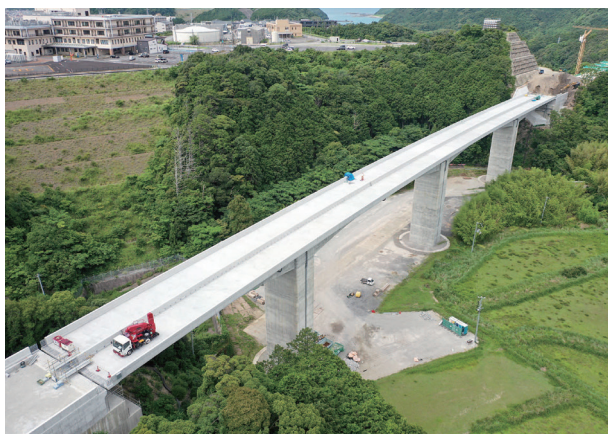
サンゴ台橋脚（紀南河川国道事務所提供）
