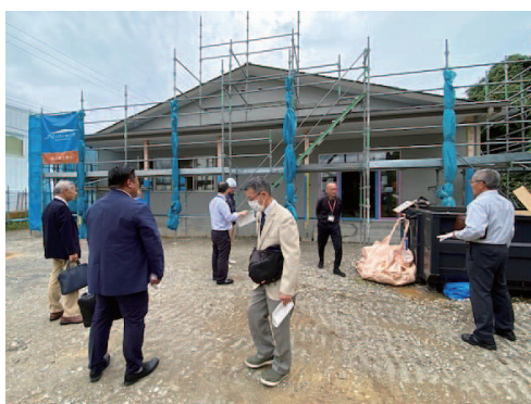
建設中の潮岬学童保育施設
