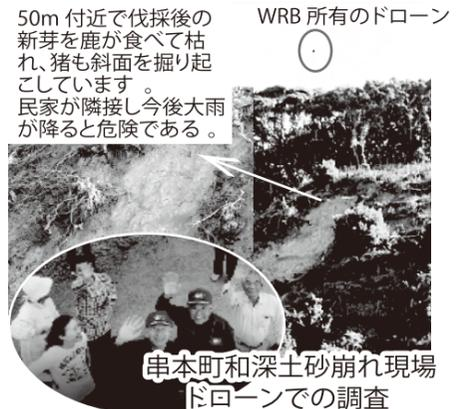
50m付近で伐採後の新芽を鹿が食べて枯れ、猪も斜面を掘り起こしています。民家が隣接し今後大雨が降ると危険である。WRB 所有のドローン 串本町和深土砂崩れ現場ドローンでの調査
