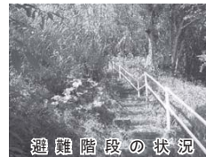
避難階段の状況
