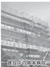
建設中の串本病院
