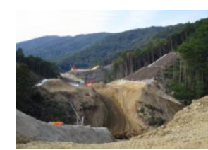
図 延伸工事が進む紀勢線
