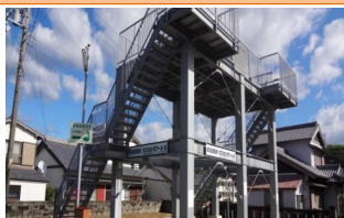
緊急避難先となる津波避難タワーの整備
