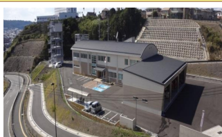
高台への消防防災センターの整備
