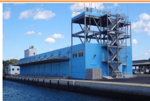
津波避難機能を備えた漁協施設の整備
