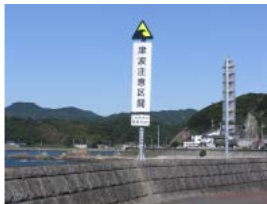
図 3-4-9 津波警戒標識
