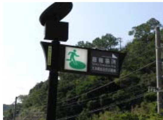
図 3-4-7 太陽電池式避難誘導標識
