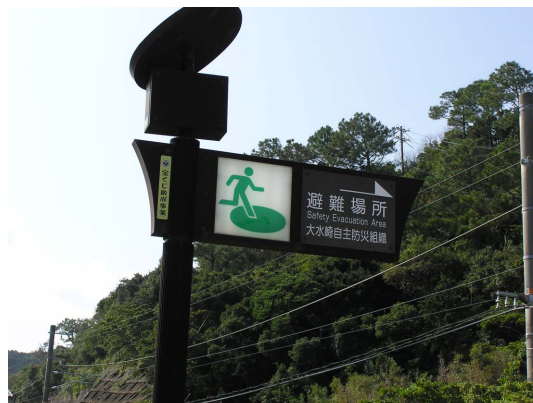
図 3-4-7 太陽電池式避難誘導標識
